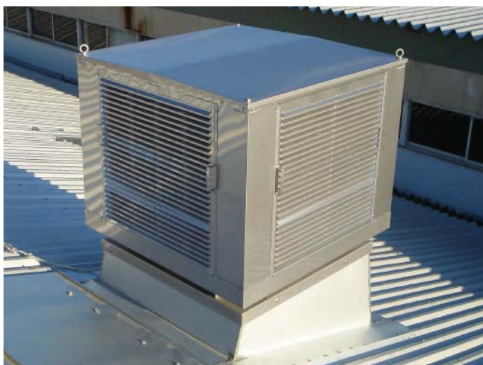
屋上取付け 折板屋根
